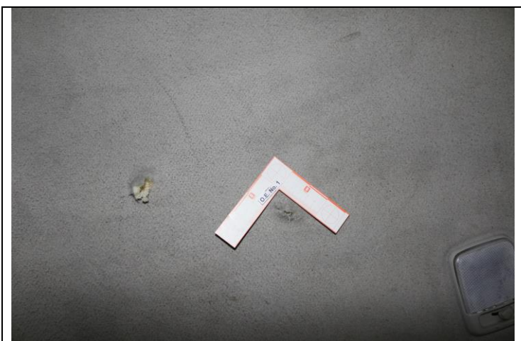
IMAGEN No. 35. Se observa techo con testigo métrico y numeración.
